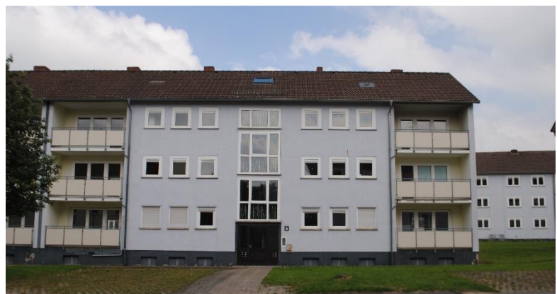
Abbildung 70: Beispiel für Wohngebäude in der Adenauerstraße, die keinen zeitgemäßen Wohnraum bieten
