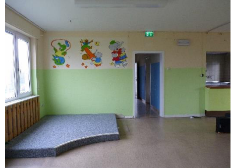
Abbildung 59: Das ehem. Lehrerinnenheim wurde zuletzt als KiTa genutzt
