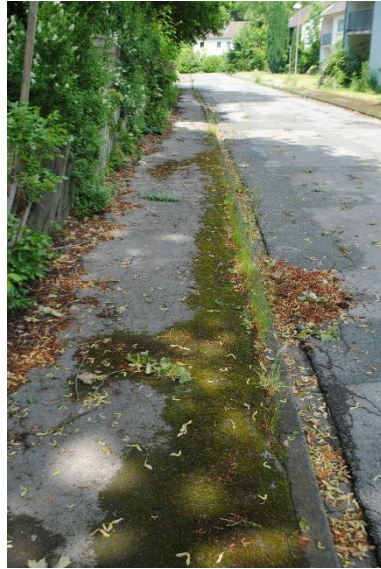
Abbildung 57: Neben dem Straßenraum muss auch die technische Infrastruktur erneuert werden
