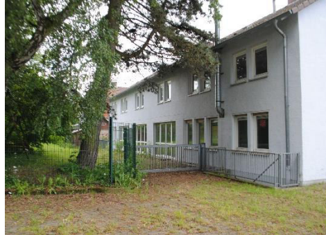
Abbildung 60: Das ehem. Lehrerinnenheim in der Braunschweigerstraße
